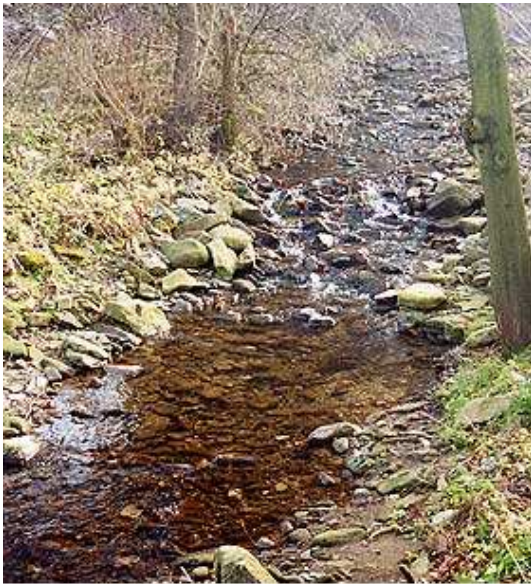
Prawidłowo ułożone U-kształtne pasmo głazów utworzyło głębozkę i garb poniżej - zwraca uwagę właściwe umocnienie brzegów głębozki
