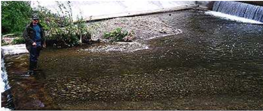
Efekt czyszczenia żwiru w basenie wypadowym nieprzekraczalnej dla pstrągów zapory
